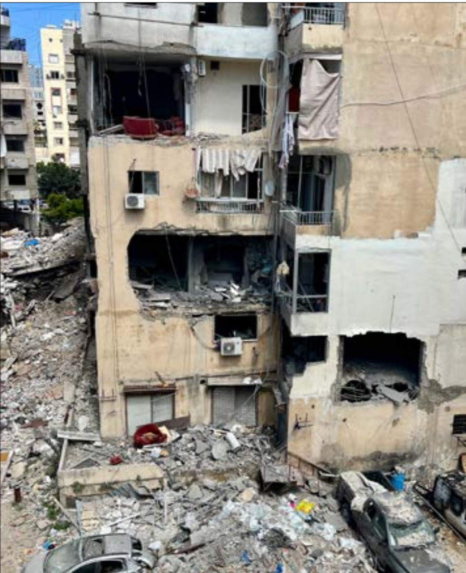
انار القصف على مبنى سكني في صور (على حشيش)
