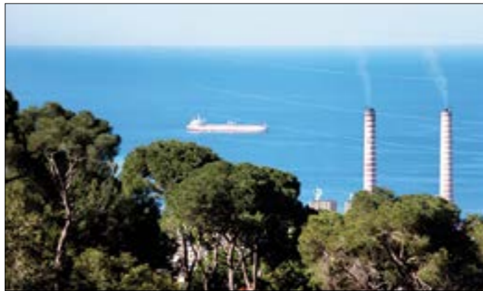
محطته الغاز التي هي خزانات مؤسسة الكهرباء، بعيد جا عن القنات (هيلم الموسوي)
